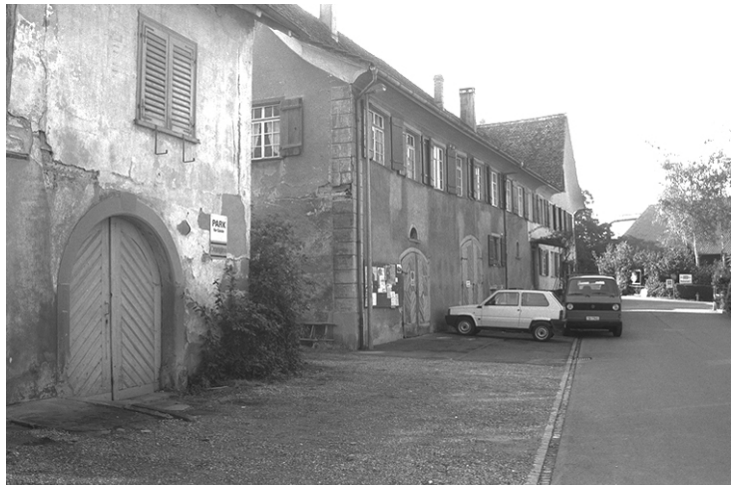
Alte Speichergebäude am ehemaligen Hafen in Uttwil. Abb. 13 (SP, 4. 10. 1995)
