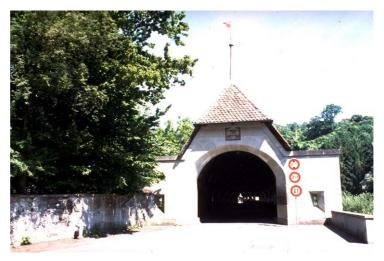
Auch bei der nördlichen Einfahrt ist in der Dachkonstruktion ein Wappen angebracht. Es besteht aus stark verwittertem Holz und zeigt ebenfalls einen Reichsadler und zwei Berner-Bären. Die Brückeneinfahrt wird auf dieser Seite durch vier Prellsteine aus Granit und Gneis geschützt (Abb. 5). In der Fortsetzung Richtung Herrenschwanden schliesst an die Brücke eine 4 m hohe Stützmauer mit einer massiven Brüstung an.
