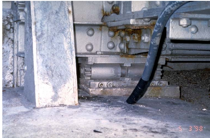
Detailansicht des Rollenlagers am Nordufer. Abb. 4 (do, 5. 3. 1998)
