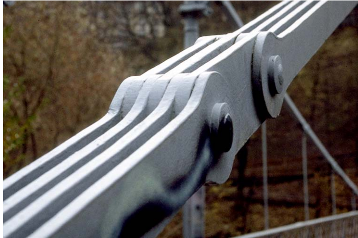
Detailansicht einer Flachkette ... Abb. 2 (GS, 4. 12. 2001)
