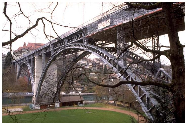
*Detailansicht des Mittelpfeilers mit der Auflage eines Bogenträgers.*
