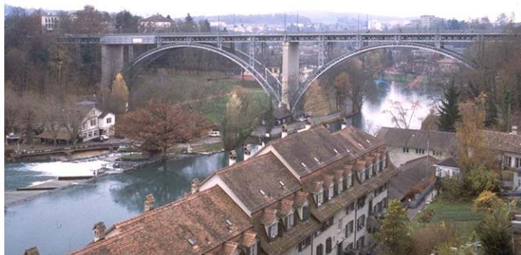
*Das Bild verdeutlicht die Versteifung der einzelnen Bogenträger mit Fachwerk-Streben und den darauf abgestützten Fahrbahn-Unterbau.*
