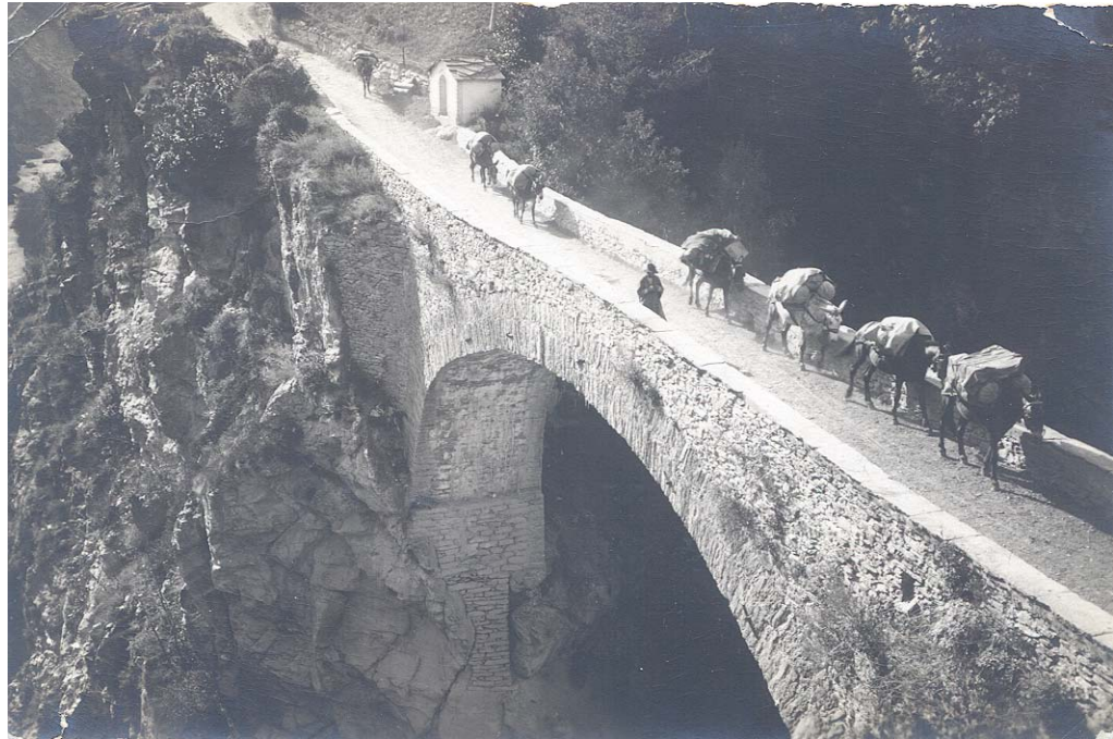
Die Chibrücke um 1930, als die Waren noch mit Maultieren transportiert wurden (IMESCH 1980: 2/114). Abb. 3
