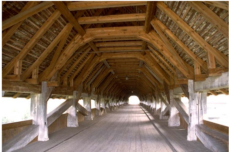
Innenansicht der Brücke. Abb. 3 (GS, 9. 5. 2001)
